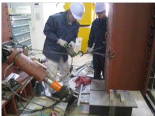
1. 水平ジャッキを取外す
