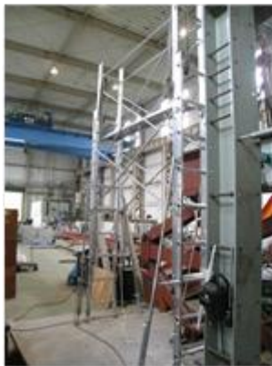
3. 足場をフォークリフトで移動させる
