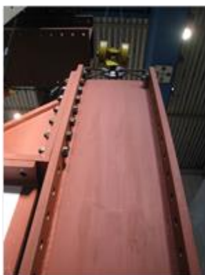
2. 梁についている治具を取外す
