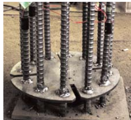
写真-1 鉄筋と定着用鉄板の様子
