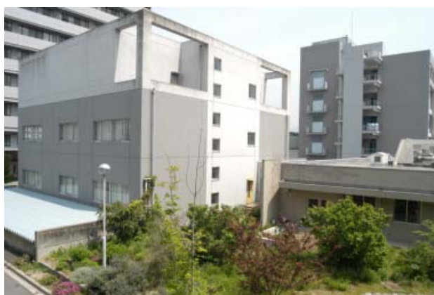
実験棟 (左) と管理棟 (右)
