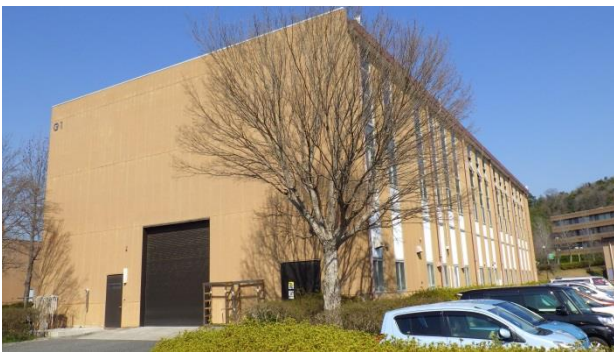
図 1.大型構造物実験棟
