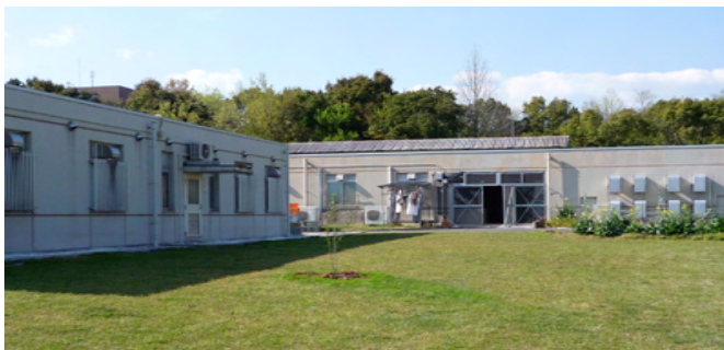
家畜環境制御実験棟
