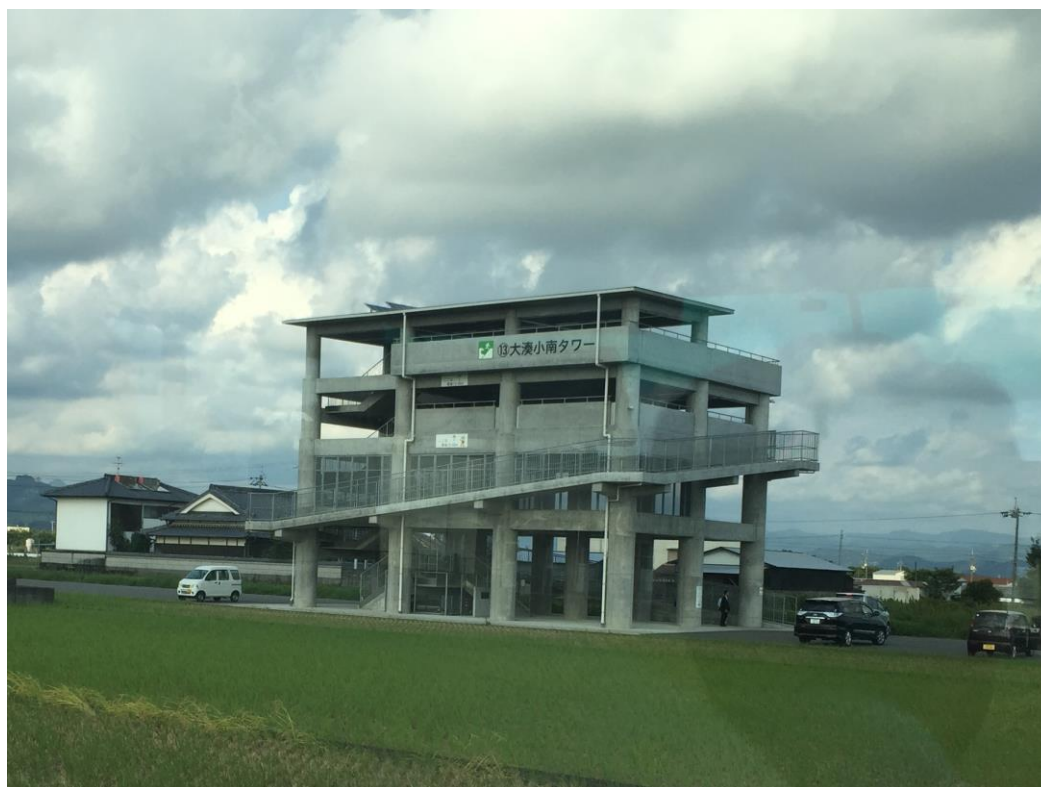
南海トラフ巨大地震津波対策の津波避難タワー（高知県南国市）
