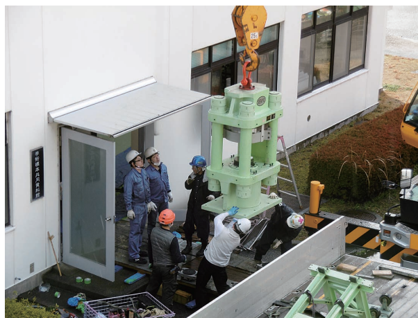
超高压高温発生装置の移設の様子
