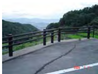
図 4.4a 福成寺進入道
