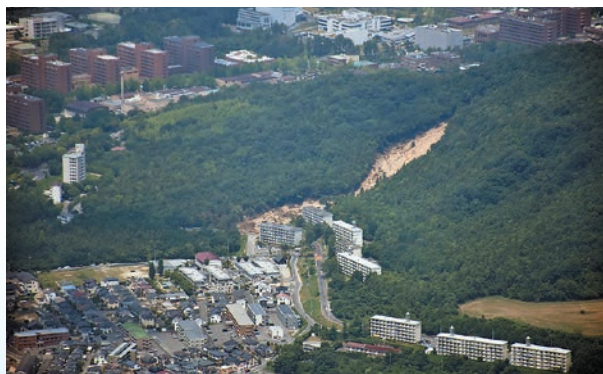
写真 がらが山の南斜面の崩壊と広島大学東広島キャンパス (2018年7月25日撮影)
