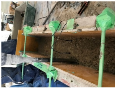
図 6.打設(パイブレータで締固め)
