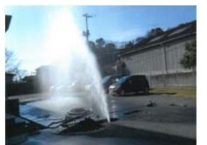
屋外埋設給水管の漏水
